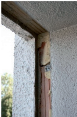
Fensteröffnung nach dem Ausbau des alten Fensters mit der Demontagesäge
