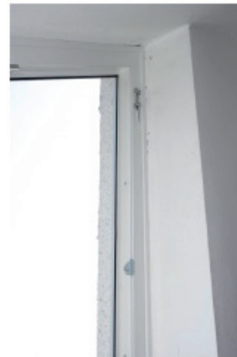
Neu eingebautes Fenster
